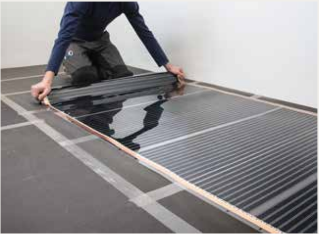
2 Instale el sistema multicapa QuickHeat.
