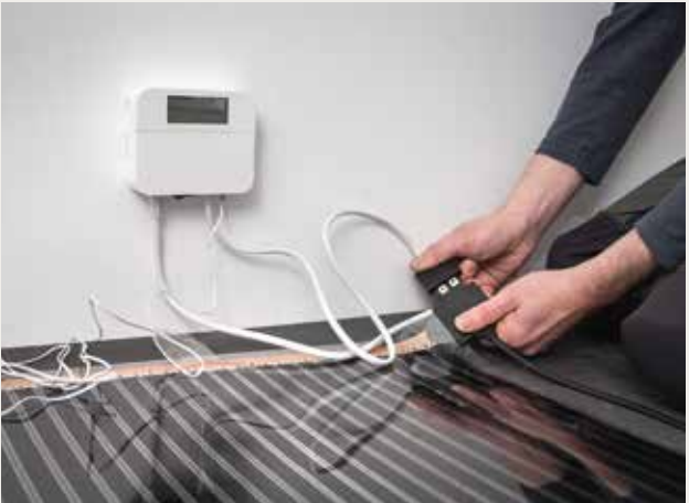
4 Monte el controlador y conéctelo a la lámina de calefacción.
