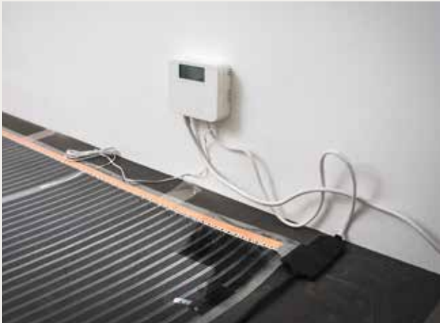
5 Conecte el enchufe de alimentación del controlador a la toma de pared.
