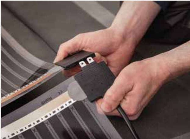
3 Conecte/una las láminas mediante sistema de clic.
